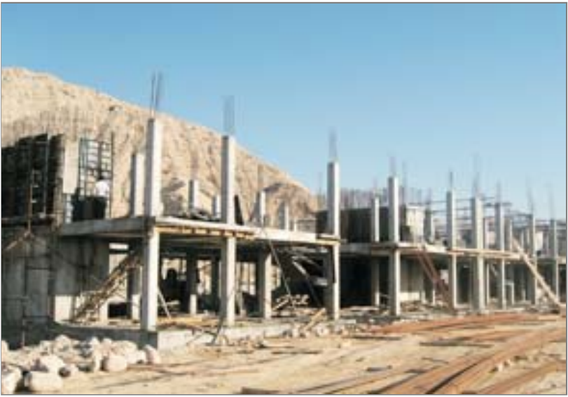
■ اجرای پروژه مسکن مهر بندر خمیر
