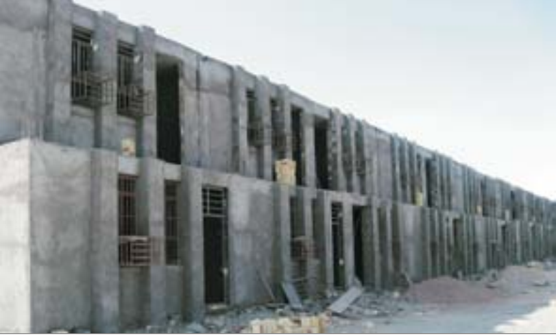
■ مجتمع مسکونی ۳۰۰ واحدی اجاره داری در حال اجرای ملوانان
