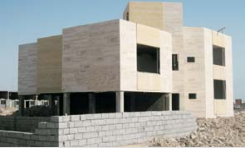
■ مجتمع سه واحدی سازمانی در حال احداث بندر لنگه
