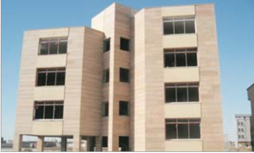
■ مجتمع هفت واحدی سازمانی در حال احداث بندر لنگه
